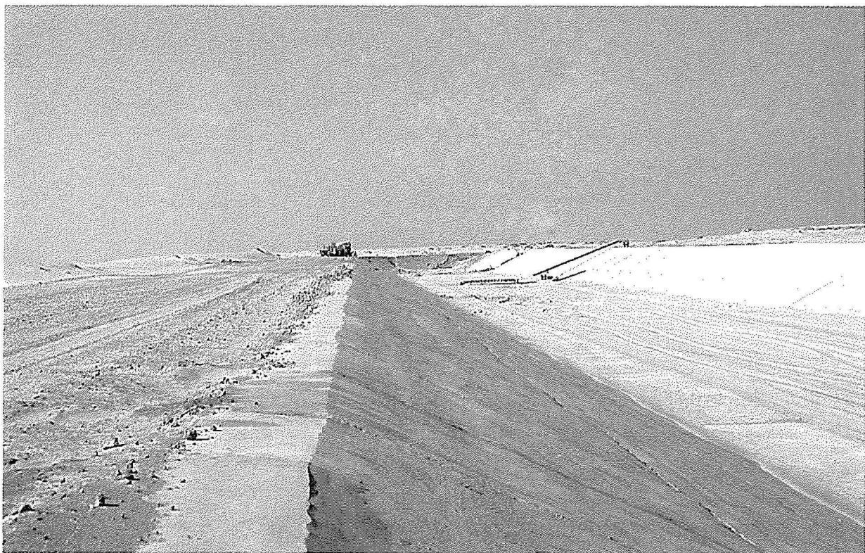
Photo 1 : Le chantier du Canal es-Salam à la hauteur de Balouza (Nord-Sinaï). Cliché : O. SANMARTIN, novembre 1994.
